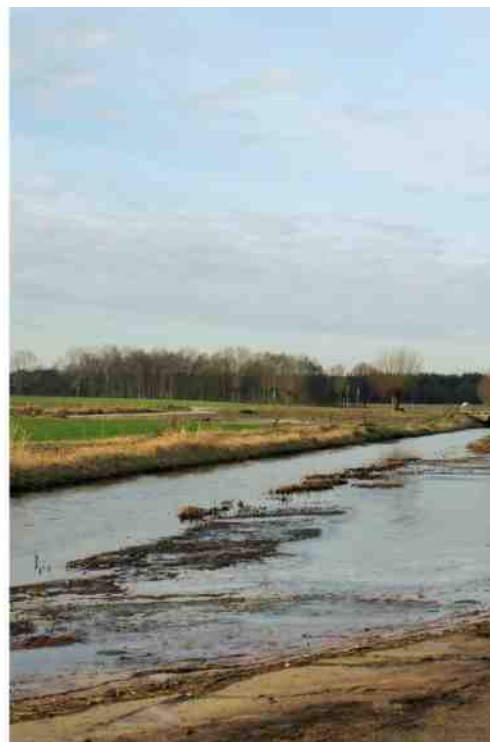
De nieuwe plas-dras-berm
